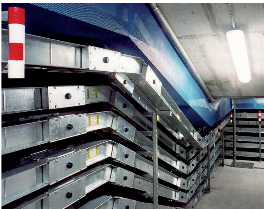
Ejemplo de distribución de alta potencia
