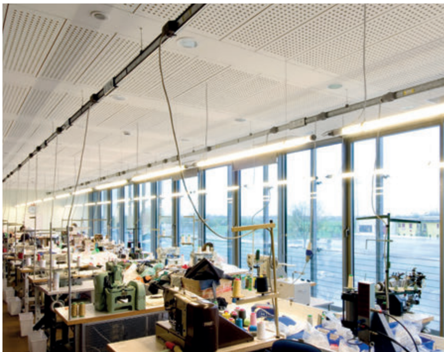
Ejemplo de iluminación y distribución de baja potencia
