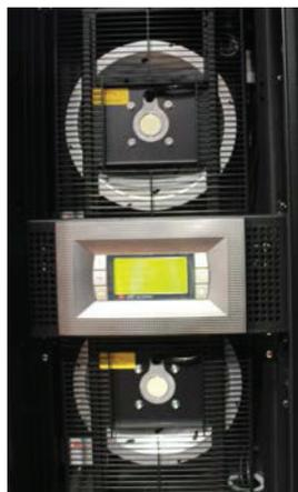
Aire Acondicionado de Precisión con panel de configuración
